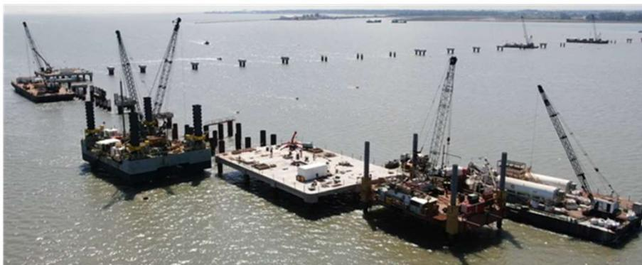
Vista del Muelle: Plataforma de operaciones, pilotes de torres de amarre, plataforma de servicios y pilotes del tramo 4 del viaducto
